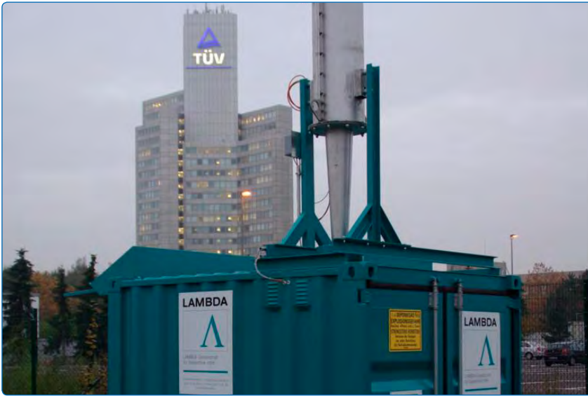
LAMBDA CHC zur Deponiegasbehandlung
